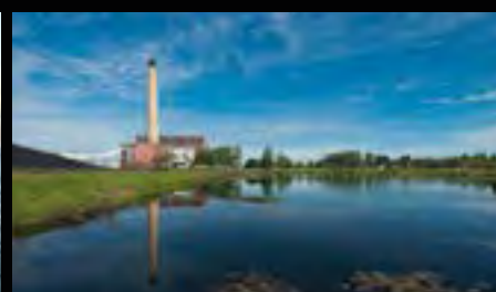
SIMEC Uskmouth power station
